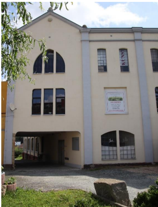
Ein Teil des Gebäudeensembles Alte Webfabrik Oderwitz
