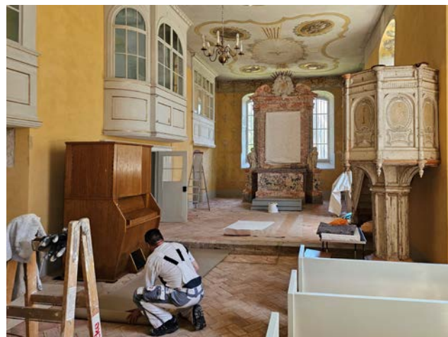
Abb. 3: Bauarbeiten in der Kulturkirche Nischwitz (Foto: LfULG, Markus Thieme)
