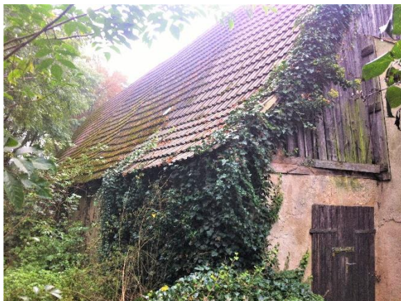
Verwunschen – die Scheune vor dem Umbau
